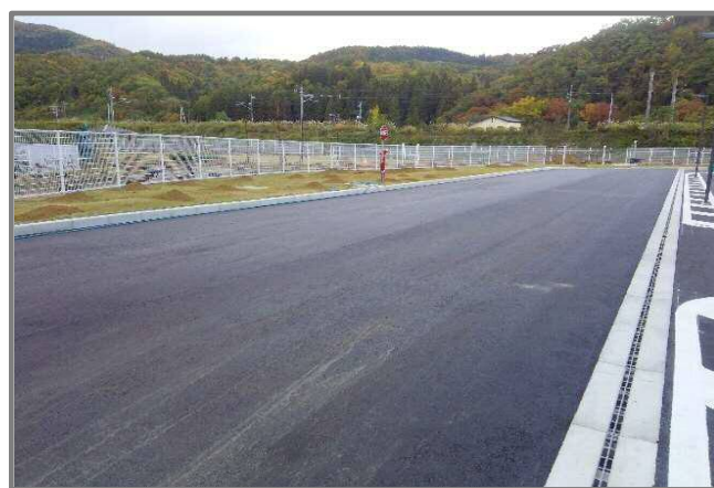
●熔融スラグ入りアスファルト舗装（西側通路）
