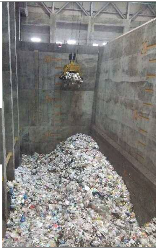
ごみピットの様子【10月26日撮影】
