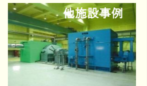
<他施設事例 蒸気タービン発電機>
